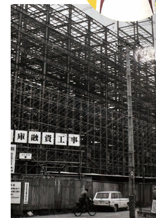
建設中のリバーサイドコーポ
