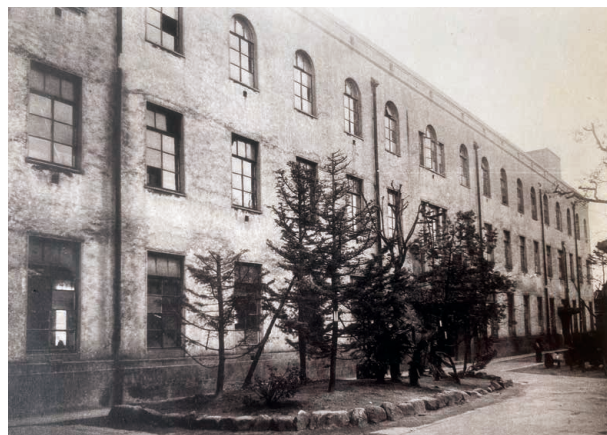
鉄筋コンクリート3階建ての校舎
