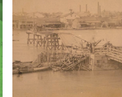
洪水によって倒壊・流出した天満橋
